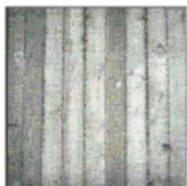
Figura 37.5 - Variazioni di colore sulla superficie in evidenza poche ore dopo la rimozione delle casseforme
