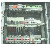
Esecuzione di lavori su quadri elettrici, ossia di una struttura assemblata contenuta in un involucro rigido, costituita da apparecchiature di interruzione, comando e controllo a bassa tensione, oltre che da sbarre, cavi, morsetti, segnalazioni e quanto necessario per la loro corretta interconnessione e per il relativo comando e controllo. Tale struttura ha la funzione di alimentare e, nel caso di guasti o manutenzioni, di scollegare elettricamente le utenze elettriche ad essa connesse.
