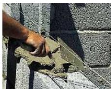
Esecuzione di intonacatura interna su superfici sia verticali che orizzontali, realizzata a mano.
