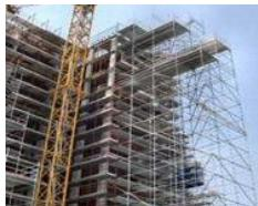
Il ponteggio fisso è un'opera provvisoriale realizzata per eseguire lavori ad altezze superiori ai 2 metri. Si tratta di una struttura reticolare realizzata con elementi metallici.
