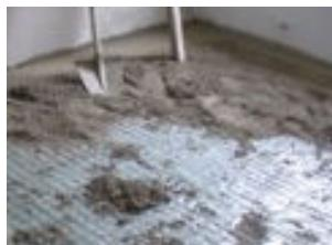
Trattasi della demolizione di pavimenti e rivestimenti, compreso il relativo sottofondo con l'ausilio di mazza e scalpello o martello demolitore elettrico e accatastamento del materiale di risulta nell'ambito del cantiere.
